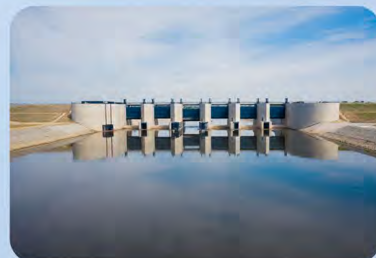
Ryc. 1. Budowla przeciwpowodziowa zbiornika Racibórz Dolny (https://www.gov.pl/web/wod-polskie)
