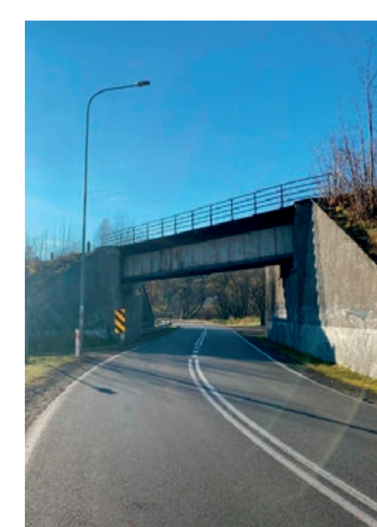
Fot. 4 Odcinek szlaku prowadzący wzdłuż drogi nr 35 (fot. autor)
