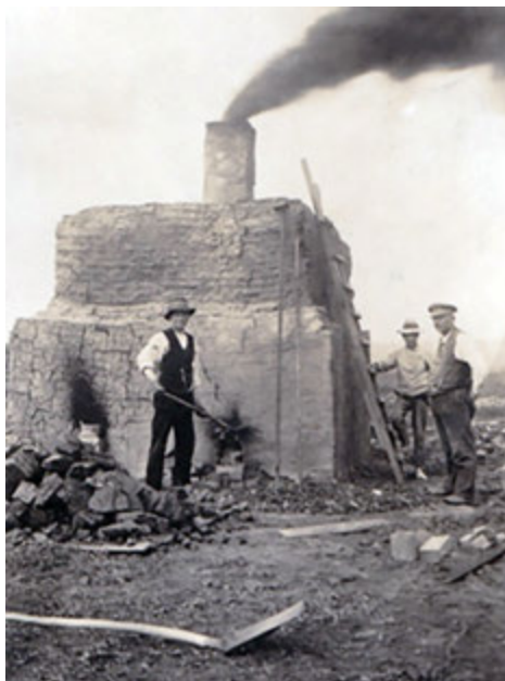
Ryc. 2. Piec mielerzowy do wypału cegieł w cegielni Rothaus, dziś Osiny koło Opola Fot. Urs Zimmermann, przed 1916 r.
