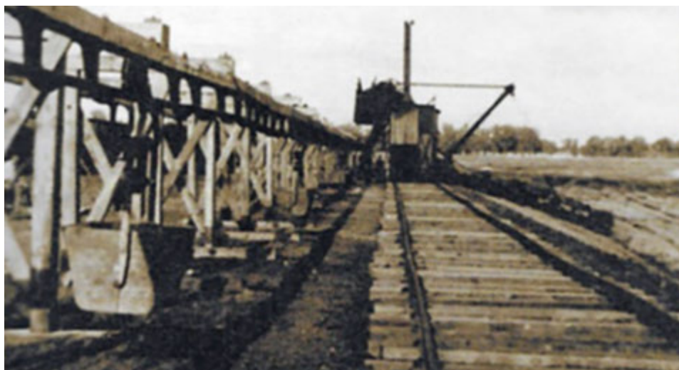
Ryc. 6. Koparka parowa i kolejka linowa w Rudniczu Źródło: Fundacja Co Pozostało?
