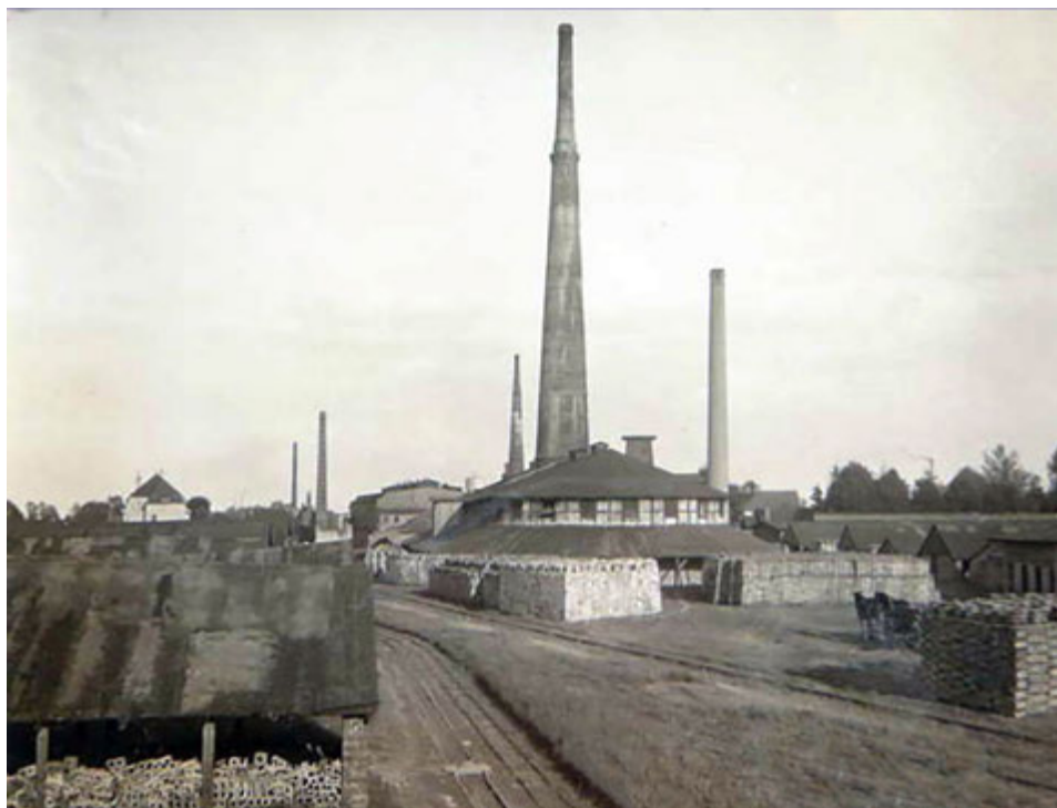
Ryc. 5. Piec kręgowy (tzw. hoffmanowski) na terenie cegielni Rudnicze na zdjęciu z okresu międzywojennego Źródło: Fundacja Co pozostało?
